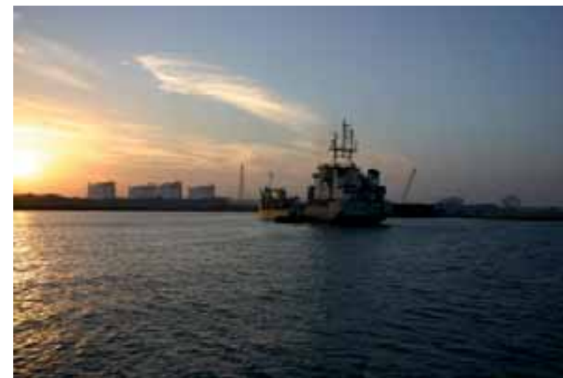
Le port en construction de l'entreprise luxembourgeoise Jan De Nul Group à Ras Laffan au Qatar servira à accueillir des navires pour transporter du gaz
