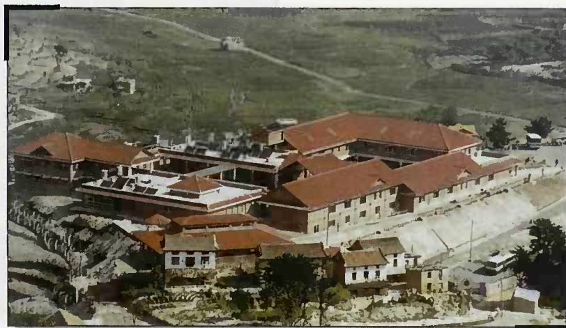
Vue aérienne de l'hôpital pour enfants handicapés et brûlés, à Banepa. Cet hôpital a été construit grâce à l'aide du gouvernement luxembourgeois, de la ville de Luxembourg et de l'ONG de la FNEL.
