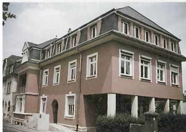
Admirablement restaurée en 1994-96: l'ancienne Maison PESCH héberge les services techniques communaux
