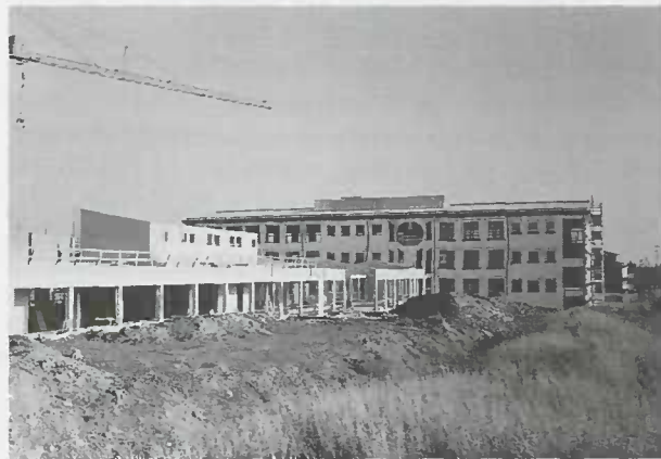
... le Centre scolaire et sportif en voie de réalisation...
