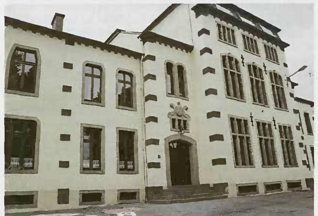
Les écoles de ROSPORT construites en 1908-1910, bâtiment qui aux origines hébergea les habitations pour le personnel enseignant, ainsi que le secrétariat communal
