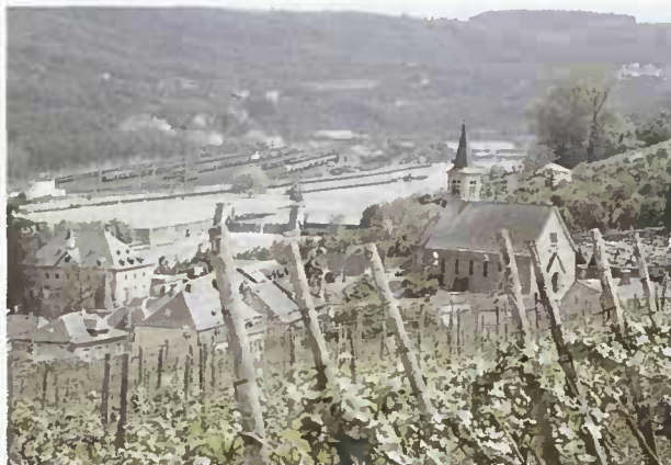
Riante localité, SCHENGEN descend, flanquée de vignes prometteuses d'excellents crus, vers la MOSELLE, son trafic fluvial et la station hydro-électrique
