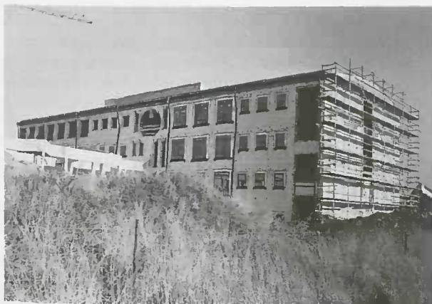
... le Bâtiment «va»: peu avant la finition du gros-oeuvre
