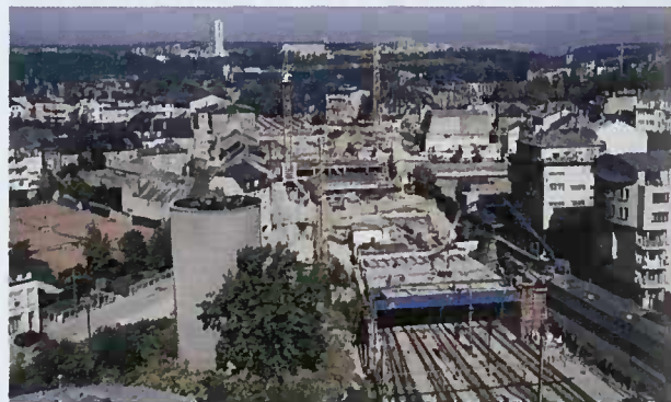
Une partie de la «Rocade de BONNEVOIE»
