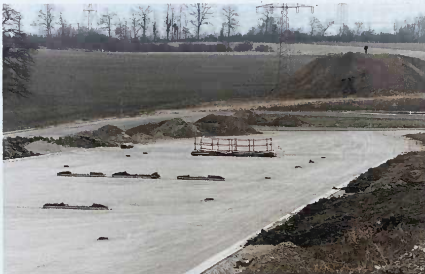
Les travaux d'aménagement des pistes sont sur le point d'être achevés.
