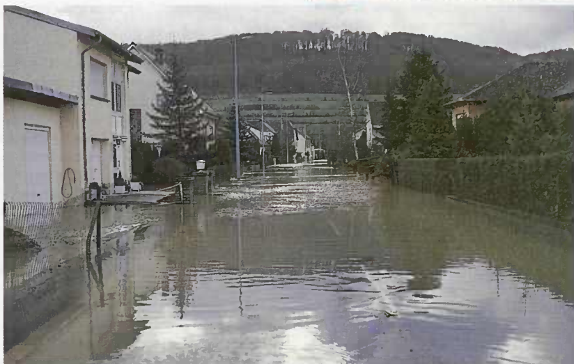
La crue des eaux à Angeldorf
