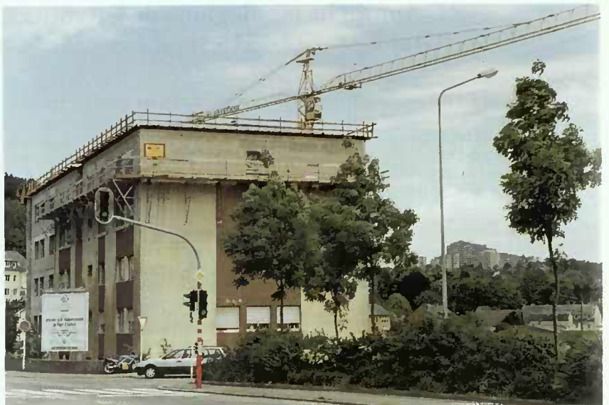
Le foyer agrandi et rénové pour travailleurs immigrés à Mühlenbach
