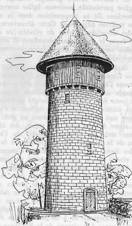
Château d'eau à Hosingen.
